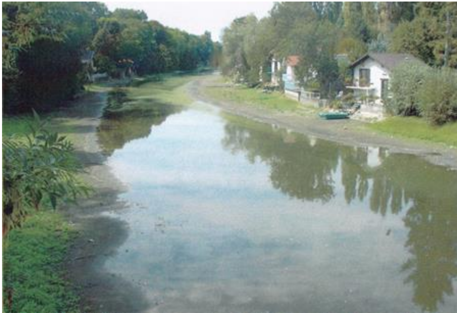
Aval pont Cotelle
