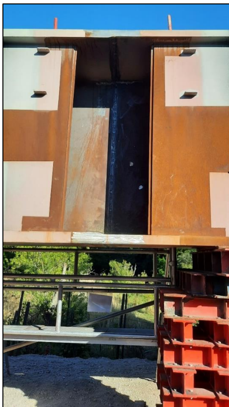
Détail d'une poutre : un homme debout peut entrer à l'intérieur
