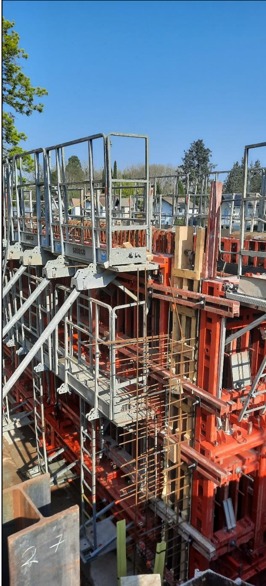
Coffrage de la partie supérieure de la culée... très technique
