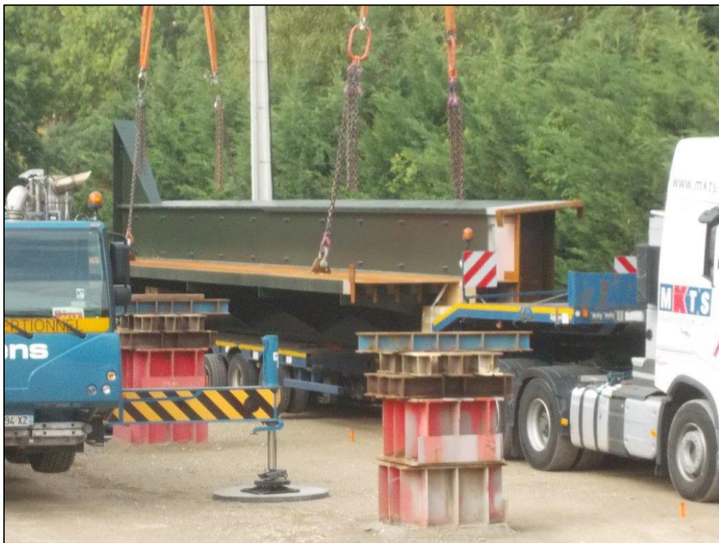
Déchargement sur la rive nord
