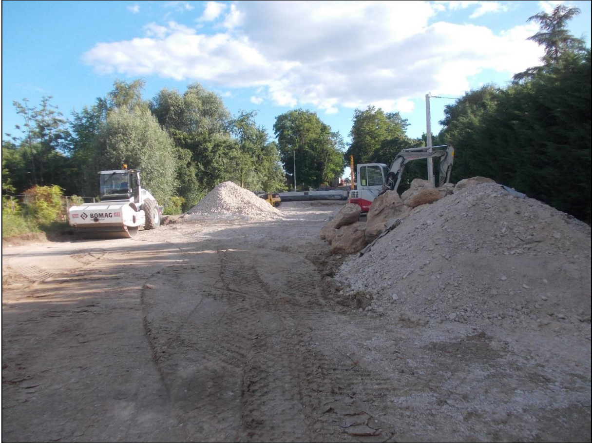
Préparation du site pour accueillir le tablier et remblaiement autour des culées
