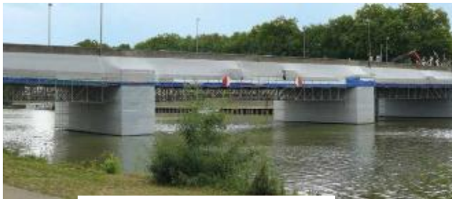
Pont de la Haute Chaine- Angers Cofiroute 2025 (source : Entrepose Echafaudages)
