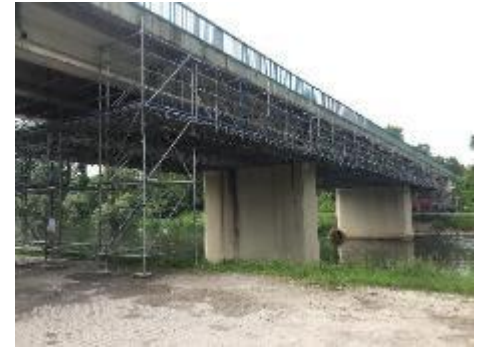
Echafaudage Viaduc de l'III - Alsace (source : Entrepose Echafaudages)
