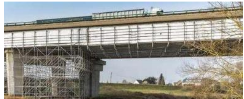
Viaduc de Criqueboeuf (source : Altrad Echafaudages)
